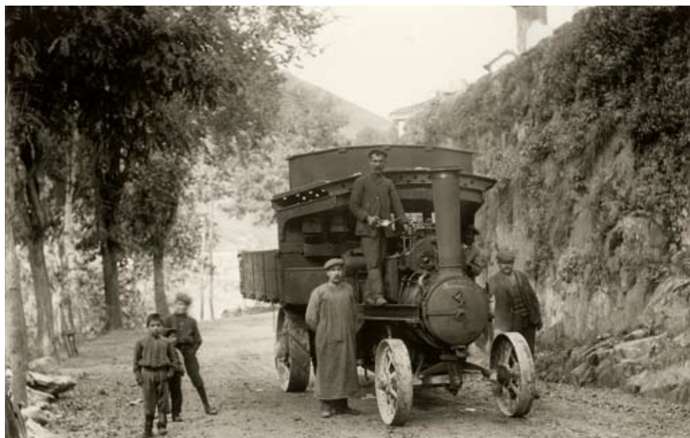
Locomóvil o locomotora a vapor de la casa inglesa Aveling & Porter empleado por la Sociedad Bosna Asturiana para transportar la madera del monte de Muniellos, en Courias (Cangas del Narcea), hacia 1907 (Fotografía de Benjamín R. Membiela).
